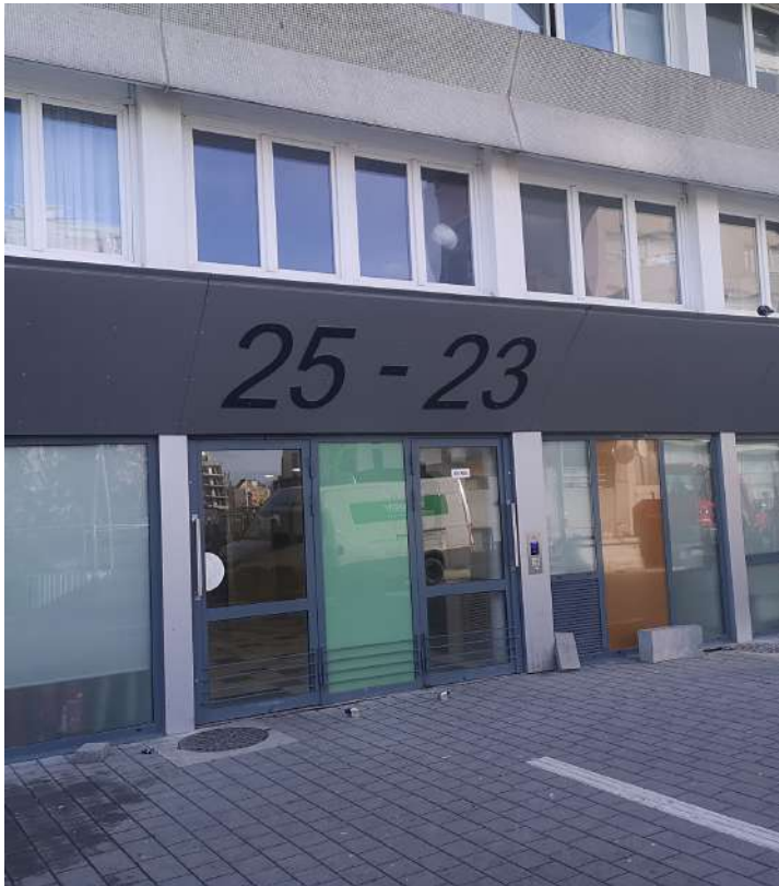
Chantier Colas Gennevilliers
