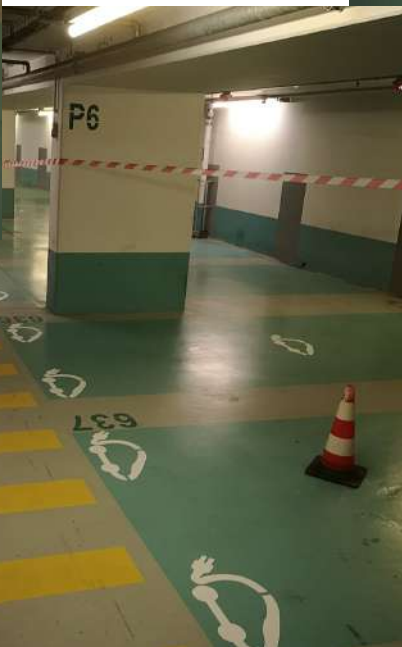
Réalisation des places de parking intérieure pour véhicule électrique à la Défense
