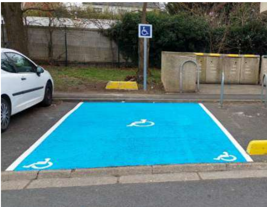
Réalisation d'emplacement de parking PMR Pour le Groupe Immobilière 3F à Brunoy
